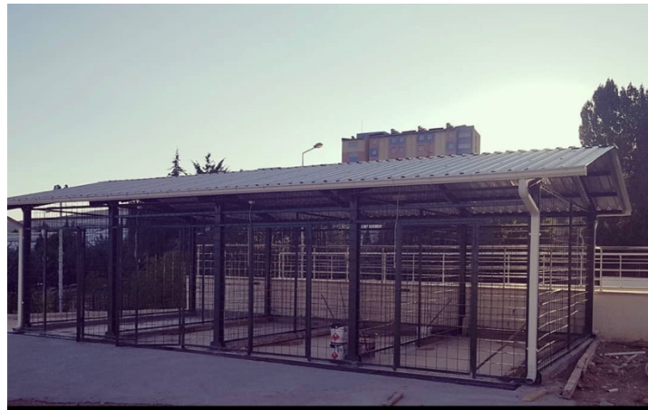
Şekil 3.2. Tamamlanmak üzere olan geçici depolanma alanları
