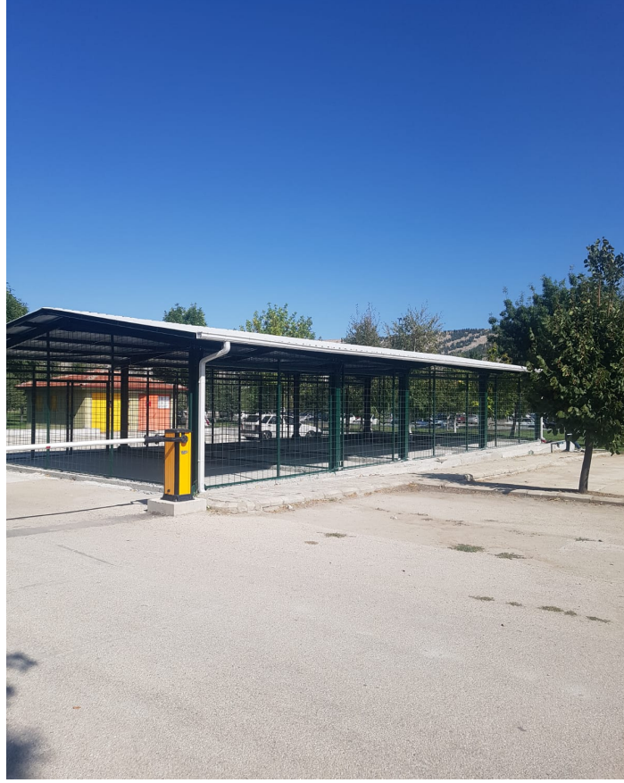
Şekil 3.3. Tamamlanmak üzere olan geçici depolanma alanları
