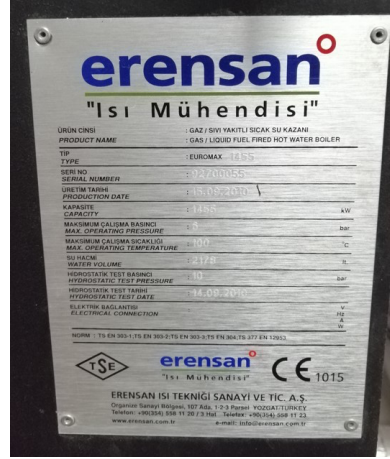
Şekil 2.7. Gaz yakıtlı sıcak su kazanı etiket değerleri
