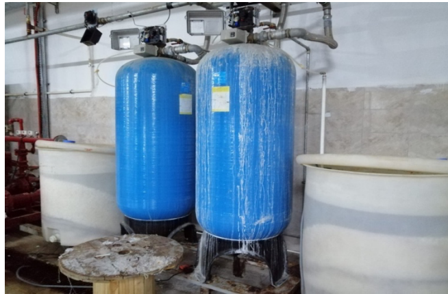
Şekil 2.11. Su yumuşatma cihazı (iyon değiştirici)
